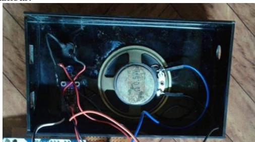
Gambar 18 Pemasangan perangkat pada box
